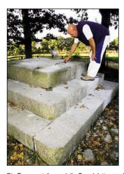
Die Treppenstufen und die Grundplatte vom Postament der Preußensäule in Groß Stresow hat Carlo Wloch bereits sicher wieder aufgebaut. Mit einem Kran sollen in der nächsten Woche die Granitquader gesetzt und bis Freitag alle Arbeiten abgeschlossen werden.
